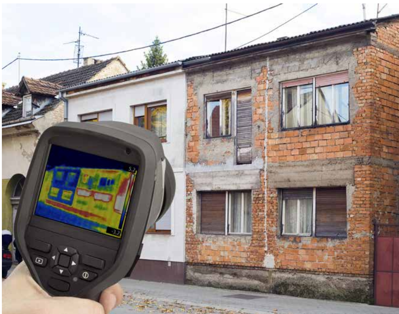
Diagnostic thermique de deux maisons avec différents niveaux d'isolation
