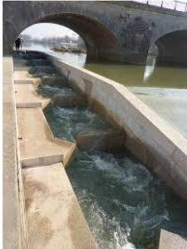
Photo 1 - Passe à poissons du barrage de Gray en Haute-Saône. Source : VNF
